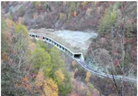
Ebenso war zu dem Datum die Steinschlagschutzgalerie vor der „Schoßbrücke“ bereits fertiggestellt und befahrbar (Bild vom „Tscharser Schnalswaal“ aus).
