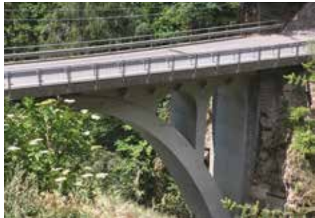
Die aus dem Jahre 1950 stammende „Hohe Brücke“ wurde im Jahre 2007 und 2008 generalsaniert (ertüchtigt) und auch die Fahrbahnbreite wurde angepasst. Während der Sanierungsarbeiten musste der Verkehr einspurig über eine „Bailey-Brücke“ geleitet werden. Bild 3 zeigt die sanierte Brücke im fertigen Zustand - unter der Fahrbahn befinden sich Wasser-, Strom- und Kommunikationsleitungen.
