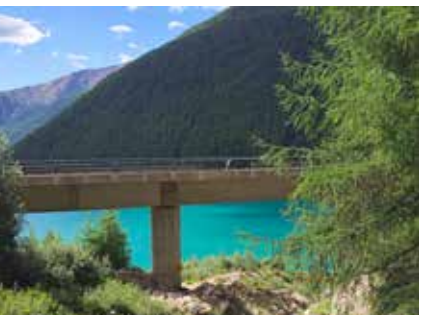
Die Brücke über den „Leiterbach“ wurde dreimal gebaut (siehe Text!)
