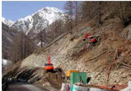
An deren Stelle wurden dann weitere Bauwerke zum Schutz der Straße errichtet.
