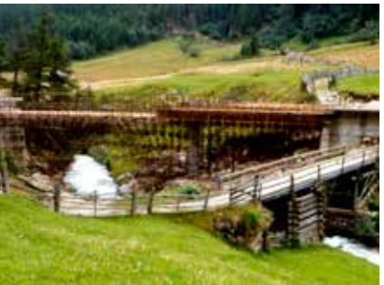
In Kurzras wurde anfangs der 80er Jahre die Straße teilweise neu angelegt. Das Bild zeigt wie sich zwei verschiedene Arten Brücken „begegnen“ (bei Untergerstgras 1982).
