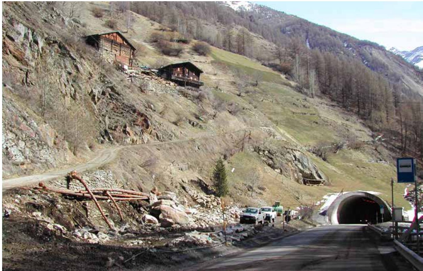
Ungefähr 20 Jahre später wurden in Außergufl mehrere Gebäude wegen Lawinen- und Steinschlaggefahr abgetragen bzw. abgerissen. Hier sind noch die „Alt-Bruggerhütten“ zu sehen. Die Gebäude des ehemaligen Schmiedanwesens sind bereits beseitigt.
