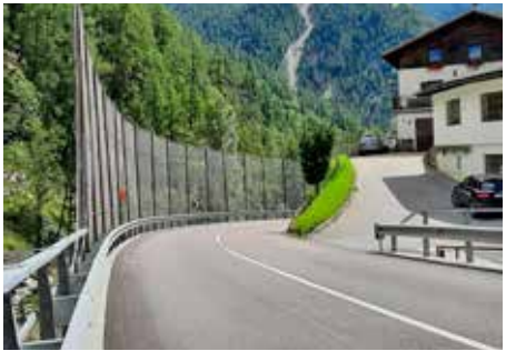
Das Bild zeigt die Brücke mit dem Steinschlagschutznetz, das in den letzten Jahren wegen des Steinschlags aus der Gegend der „Mühlköfel“ angebracht werden musste.
