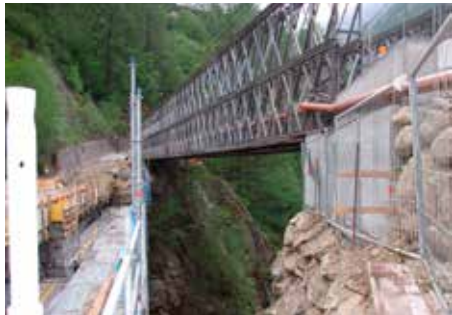
Die aus dem Jahre 1950 stammende „Hohe Brücke“ wurde im Jahre 2007 und 2008 generalsaniert (ertüchtigt) und auch die Fahrbahnbreite wurde angepasst. Während der Sanierungsarbeiten musste der Verkehr einspurig über eine „Bailey-Brücke“ geleitet werden. Bild 3 zeigt die sanierte Brücke im fertigen Zustand - unter der Fahrbahn befinden sich Wasser-, Strom- und Kommunikationsleitungen.
