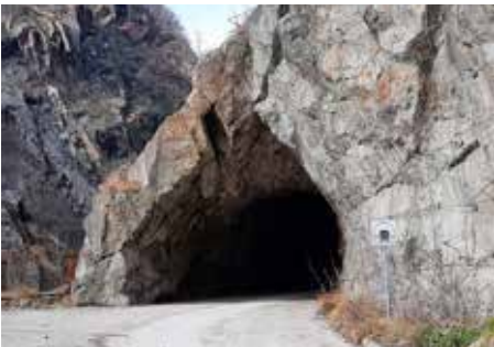
Der kurze Tunnel auf der alten Straße, der beim Transport der Stahltragseile für die Gletscherbahn auf gefährvolle Weise umfahren werden musste.
