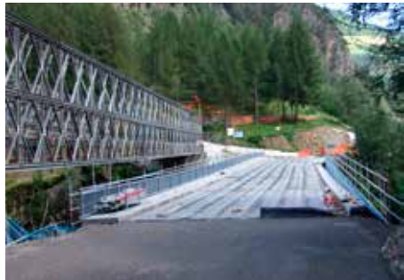
Die aus dem Jahre 1950 stammende „Hohe Brücke“ wurde im Jahre 2007 und 2008 generalsaniert (ertüchtigt) und auch die Fahrbahnbreite wurde angepasst. Während der Sanierungsarbeiten musste der Verkehr einspurig über eine „Bailey-Brücke“ geleitet werden. Bild 3 zeigt die sanierte Brücke im fertigen Zustand - unter der Fahrbahn befinden sich Wasser-, Strom- und Kommunikationsleitungen.
